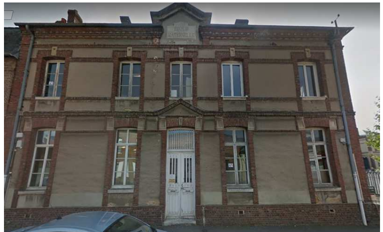
5 Logements en réhabilitation
